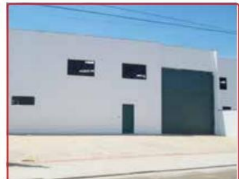
REF. 2345 - VILA IRENE Galpão com 310m 2 , pé direito de 7m, Escritório, cozinha
