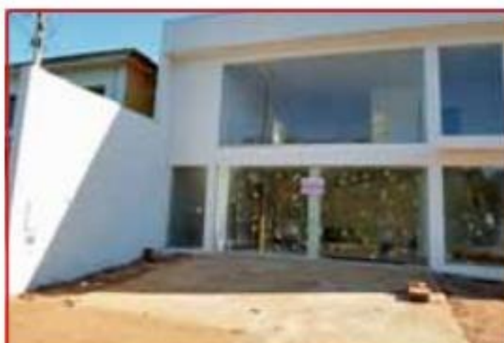
1630 - JARDIM SÃO CARLOS salão com piso superior e 04 salas
