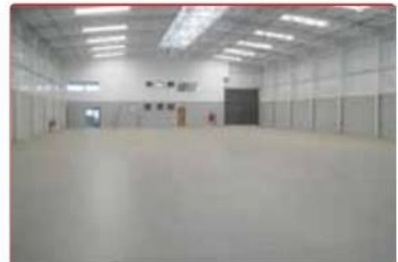
437 - CEAT Galpão com 2.700 m 2 com guarita, refeitório e mezanino.
